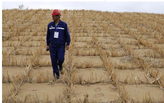
شکل ۲- پوشال های شطرنجی برای تثبیت تلماسه ها در بیابان های چین [۱۴].
